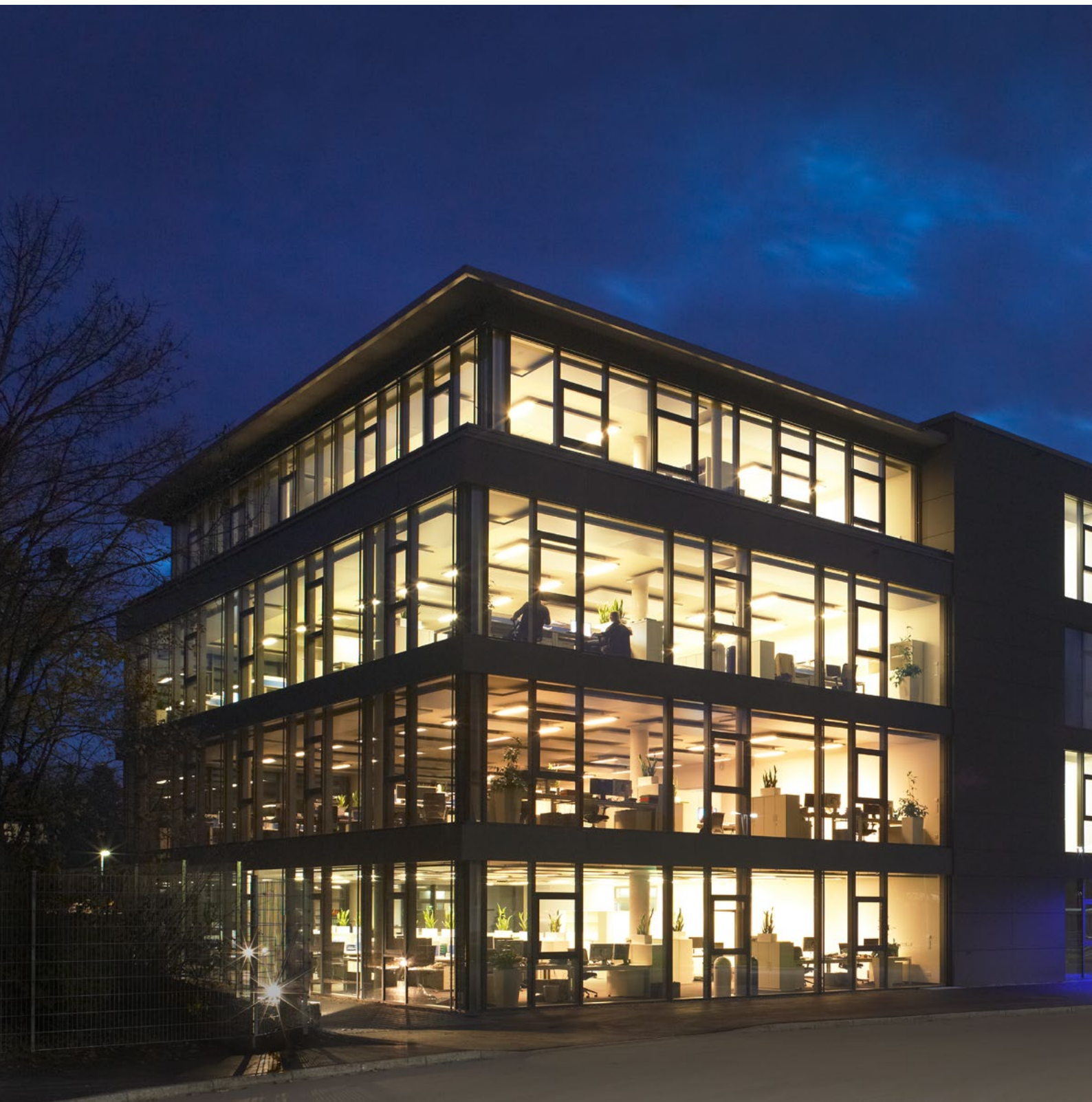
Bâtiment administratif de BHS-Sonthofen
